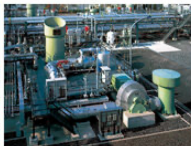
Submerged Combustion type LNG Vaporizers
